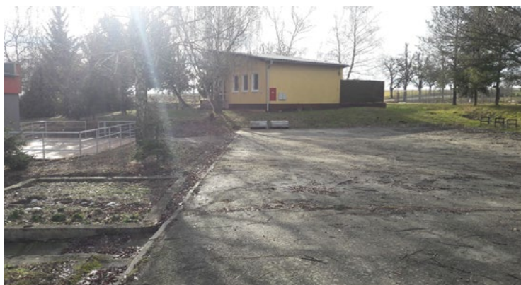
Původní stav: asfaltová plocha
