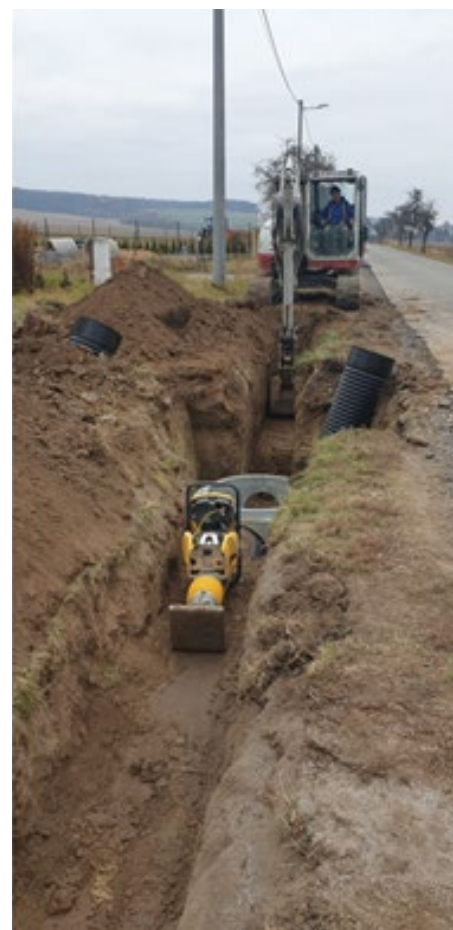
Průraz stávající betonové kanalizace jinou sítí (po provedení sondy zjištěno, že se jedná o kabely telefonu v ocelové chráničce)
