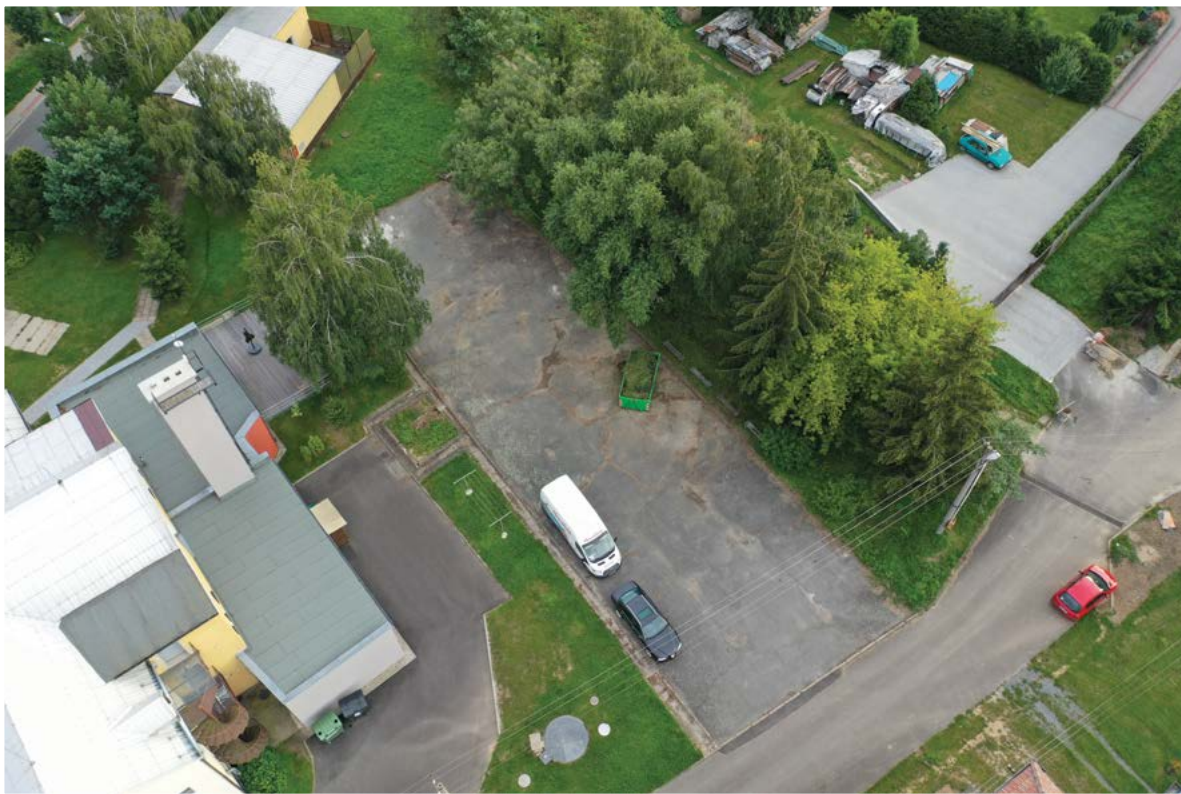
Asfaltová plocha za DZR před realizací
